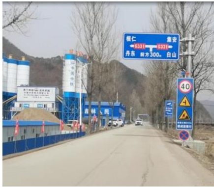
图 22 迎水-大甸子北段（K18+932～K22+871） 三级公路路基现状
