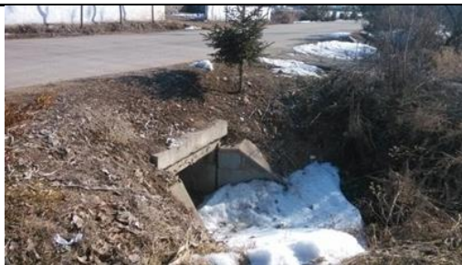
图 23 旧路涵洞现状照片
